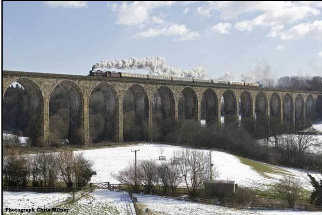
Cefn Mawr Viaduct
